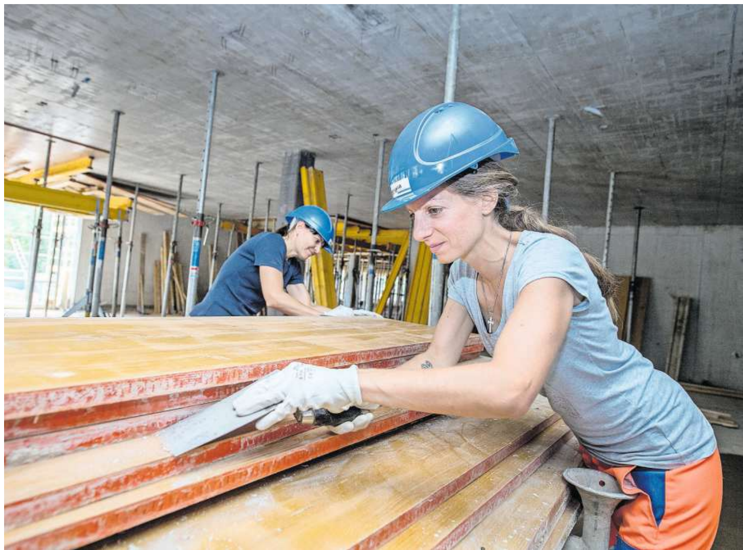
Petra Spichtig (hinten) und Sarah Zumerle schleifen Schalungsplatten ab.
